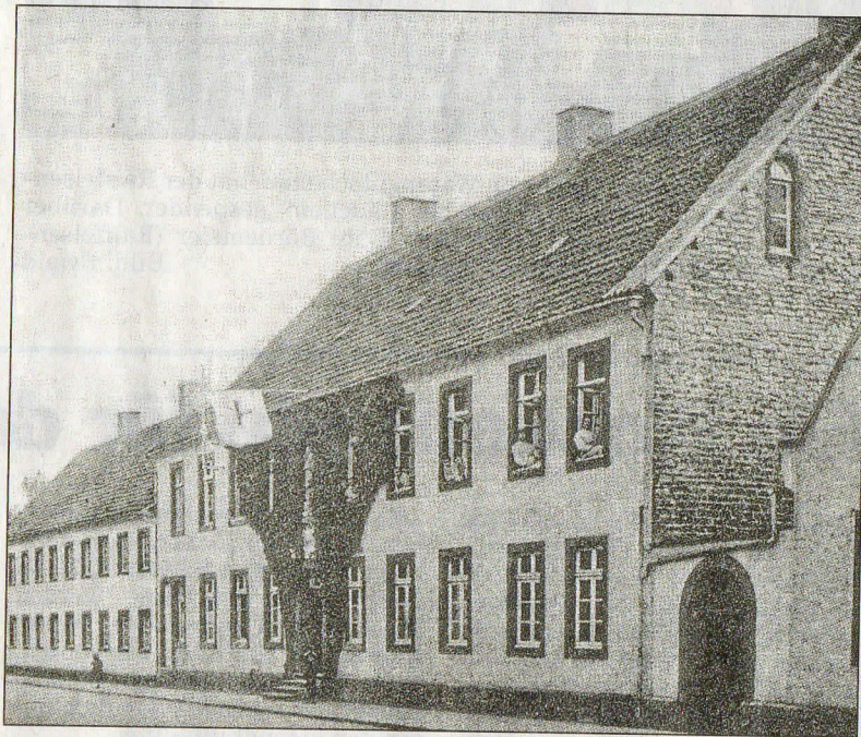
Das Vinzenzhaus wurde während des Ersten Weltkrieges als Lazarett an der Südstraße genutzt. Rechts ist die Leichenhalle zu sehen, links als das niedrige Gebäude war das vormalige städtische Armenhaus.
